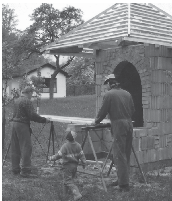
Kapelle als Baustelle
